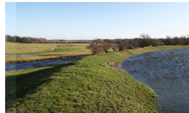
Blødt udformet dige indpasset i landskabet Vist med forhøjet vandstand efter stormen Malik Foto: Eva Sara Rasmussen, Natour
