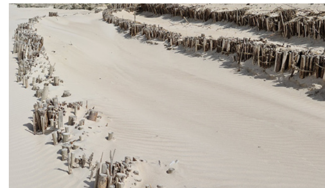
Biologisk kystsikring udført GroundPlug International i Nr. Lyngby Foto: Carsten Agerup
