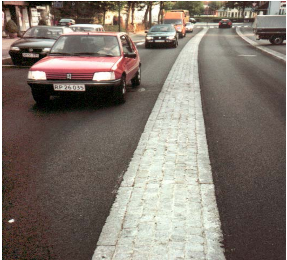
Eksempel på en midterzone som er ombygget til en midtervulst – lokalitet: Kongens Lyngby.
